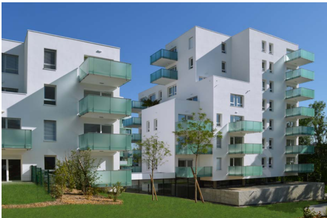
Anney, Cran-Gevrier, éco-quartier des Passerelles, îlot "terre brune", Richard Plottier, architecte
