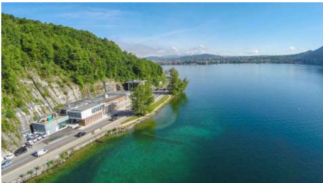
Station de pompage de La Puya à Sevrier.
