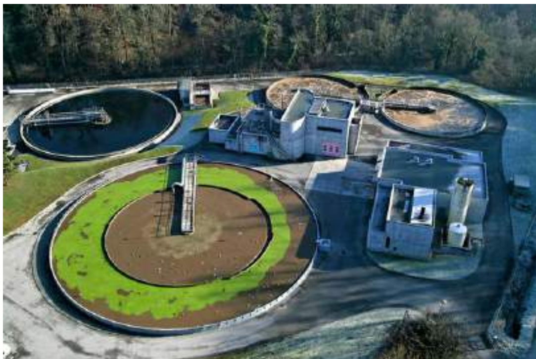
Usine de dépollution des eaux usées des Poiriers.
