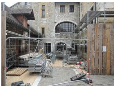
Chantier Palais de l'Île 2016 Crédit photo : Musées d'Annecy
