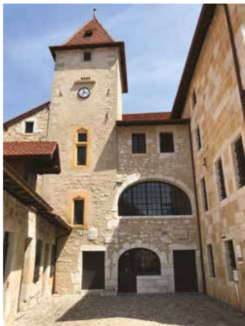
Fachada do pátio de entrada © Museus de Annecy
